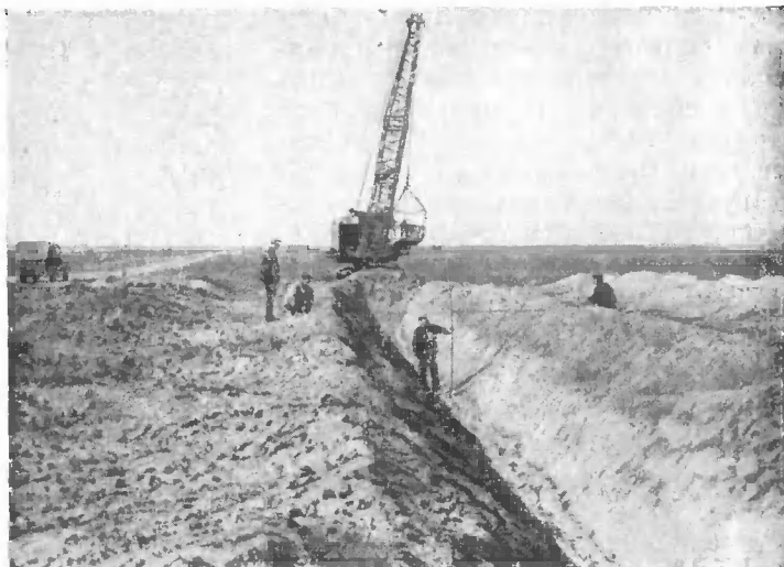
Прокладка оросительного канала
